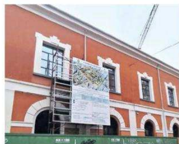
I lavori nell'ex Manifattura
