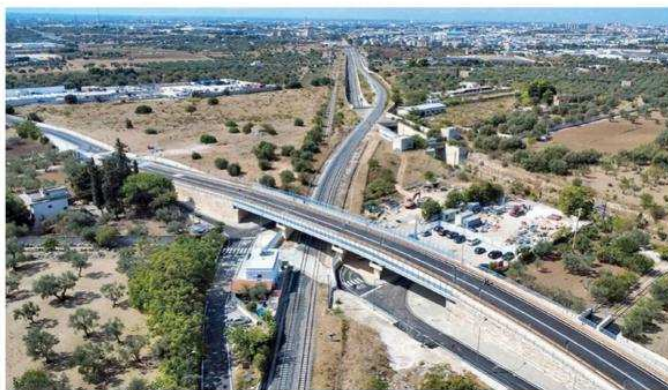
Il nuovo ponte di Santa Caterina visto dall'alto
