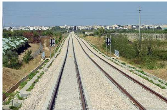
I binari L'infrastruttura delle Ferrovie del Sud Est tra Noicattaro e Putignano
