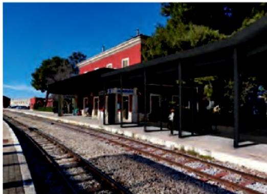
Una nuova pensilina di circa 33 metri in prolungamento di quella esistente ed a copertura del tratto di banchina che conduce al sottopasso ferroviario; rinnovamento ed adeguamento tecnologico del fabbricato di stazione; eliminazione delle barriere architettoniche ed adeguamento dei servizi ai più moderni standard di accessibilità; installazione di tornelli, monitor informativi, connessione wifi gratuita e luci a led.
