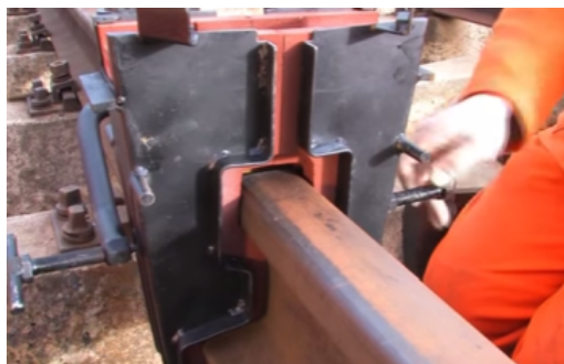
saldatura alluminotermica
