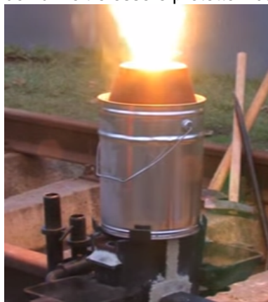
fusione alluminotermica
