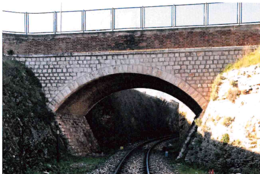
Figura 32 Sovrappasso in muratura km 21+900 – Stato Attuale
