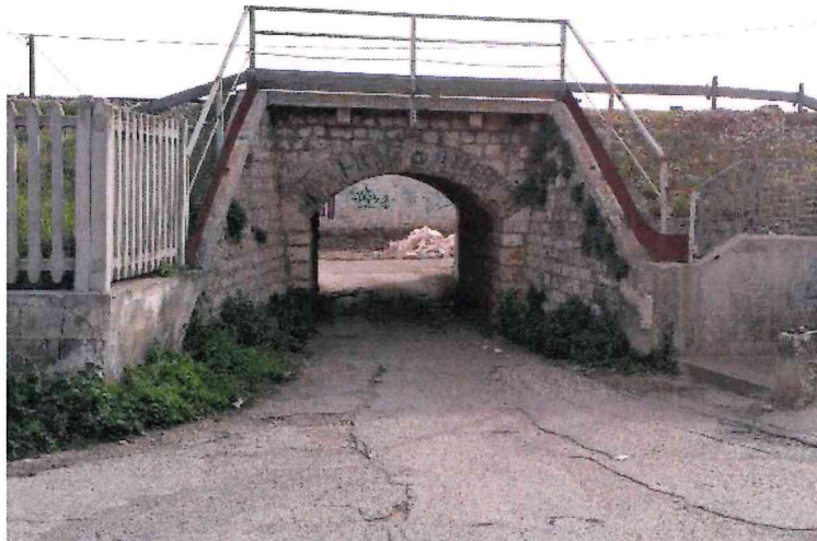
Figura 29 Sottovia km 24+323.28 – Stato Attuale – Lato Valle
