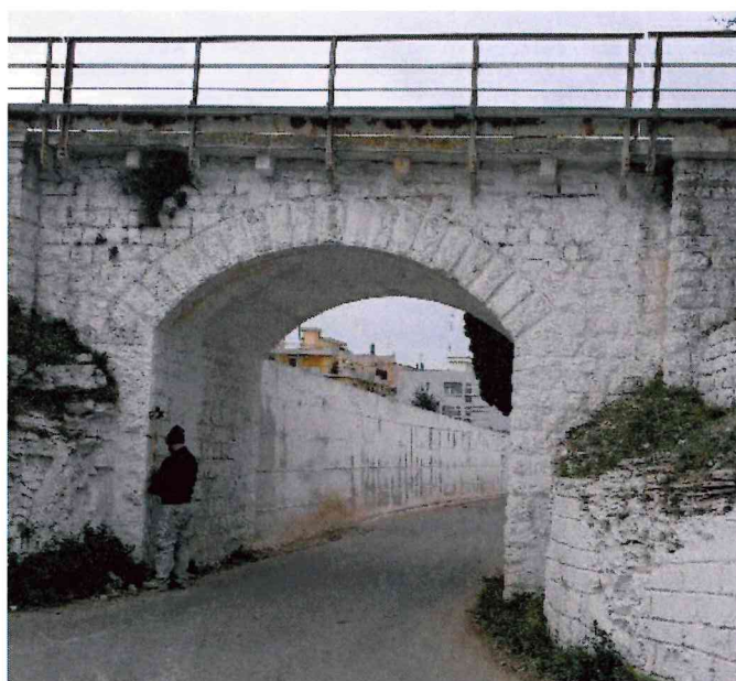
Figura 36 Sottovia km 24+190.78 – Stato Attuale
