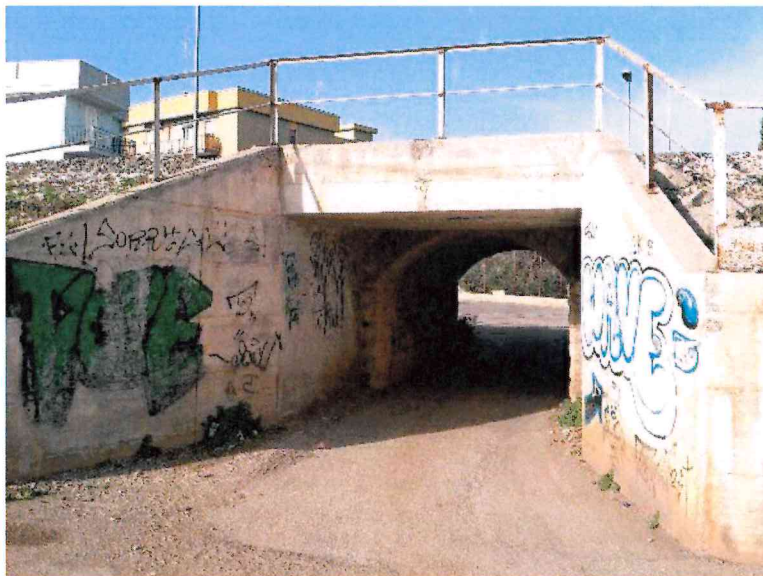
Figura 30 Sottovia km 24+323.28 – Stato Attuale – Lato Monte
