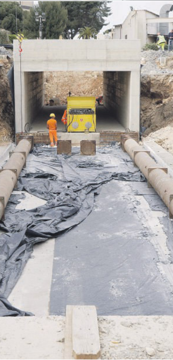
OPERAZIONE CHIRURGICA Il sottopasso ciclopedonale che collegherà la rotatoria tra via Matarrese e via Bellomo e la rotatoria di viale, realizzata grazie all'uso della tecnologia di spinta oleodinamica
