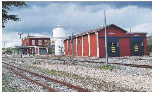
GENZANO DI LUCANIA La stazione ferroviaria delle Fal dopo i lavori di ristrutturazione. La riapertura della tratta per San Nicola di Pietragalla è avvenuta dopo otto anni di lavori
