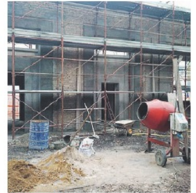
FAL Lavori alla stazione
