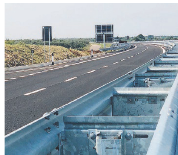
STRADA STATALE 96 Il nuovo tratto inaugurato ieri
