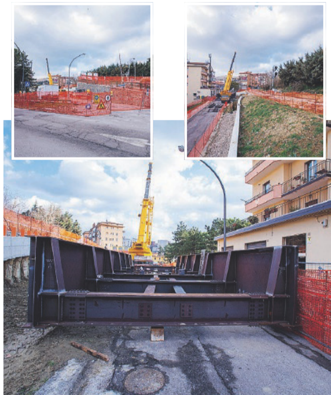
FAL Lavori in corso [foto Tony Vece]
