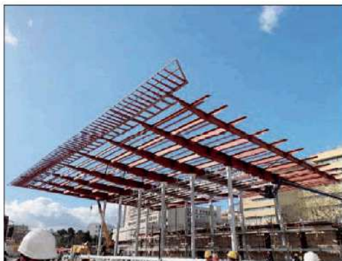
La pensilina al centro della stazione di Matera Centrale delle Fal
