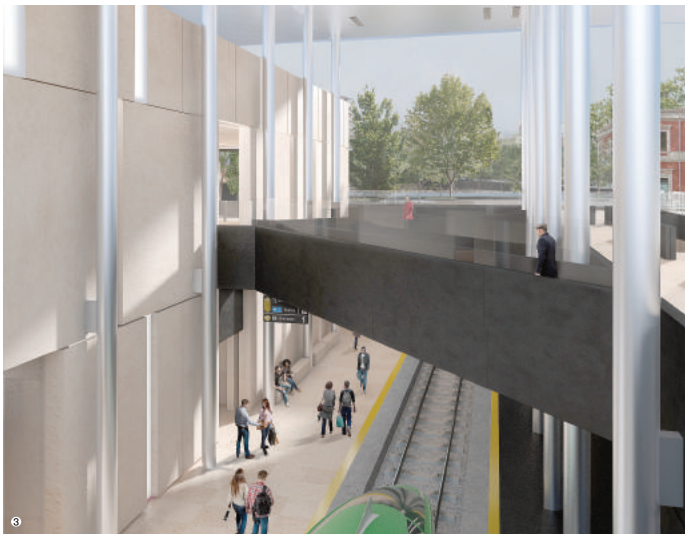
1. Il cantiere della stazione di Matera Centrale progettata da Stefano Boeri come si presenta ora 2. Il rendering della stazione una volta terminata 3. La pensilina sovrasta di 12 metri il flusso di visitatori, mentre i binari scorrono a quota meno sei metri
