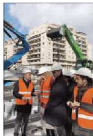
Il cantiere della stazione centrale Fal
