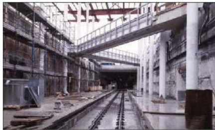
I lavori nella stazione centrale delle Fal
