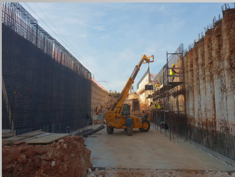
Armatura pareti gallerie/Spostamento condotte Via Tasso
