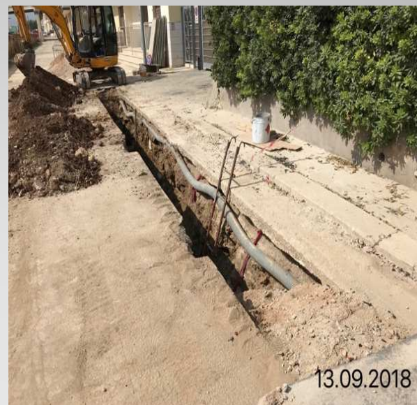
Armatura pareti gallerie/Spostamento condotte Via Tasso
