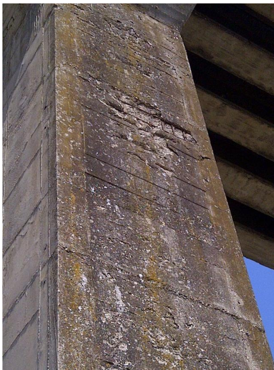
Figura 9.4 - degrado corticale
