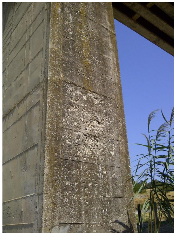
Figura 9.5 - degrado corticale
