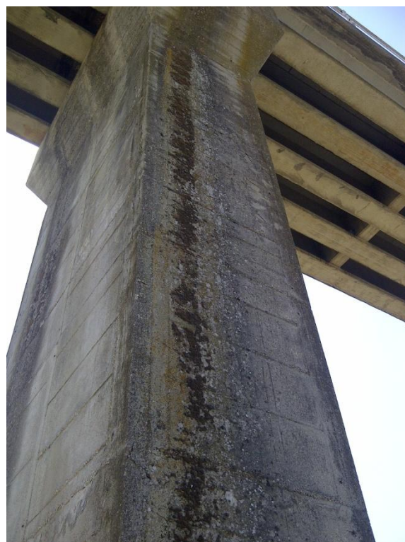
Figura 9.2 –Viadotto Km 70+614 - Pila
