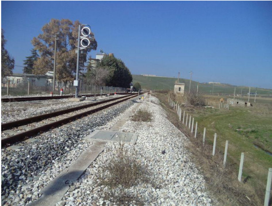
Foto 3 -Vista in corrispondenza della stazione
