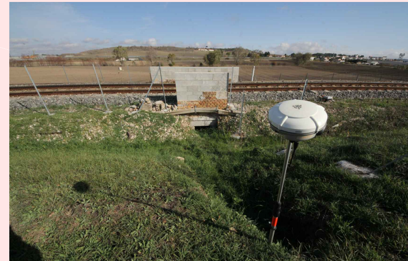
VISTA LATO MONTE
