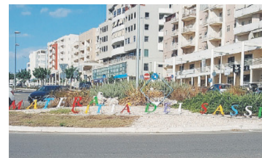
RIMESSA A NUOVO La rotonda dopo l'intervento
