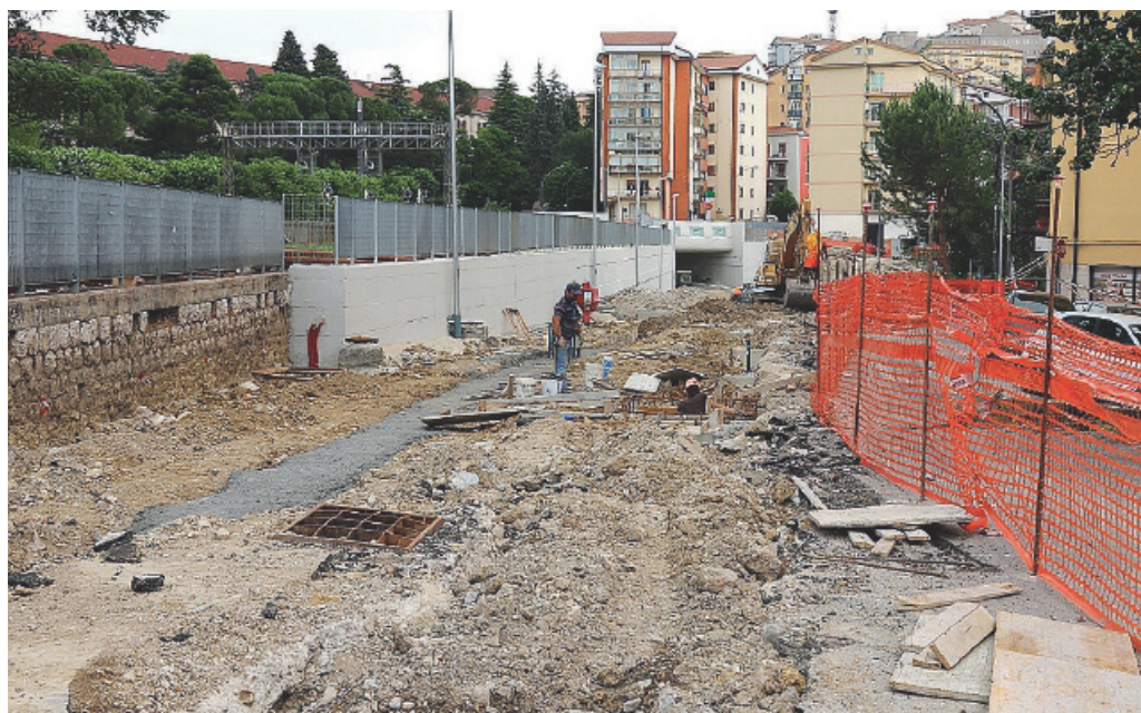
CANTIERE Una recente immagine dei lavori al sottopasso [foto Tony Vece]
