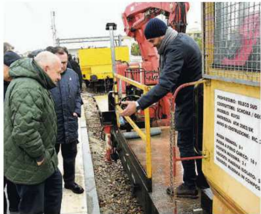
Il sopralluogo sul cantiere della Bari-Bitritto: a giugno prossimo la fine dei lavori
